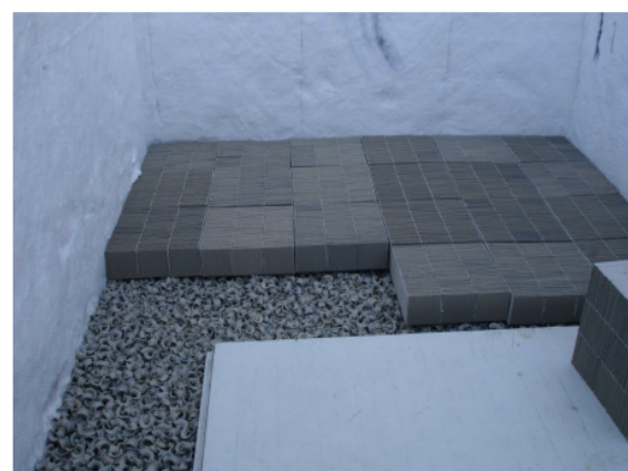
Рис.3 Укладка керамических сотовых блоков внутри вертикальной башни
