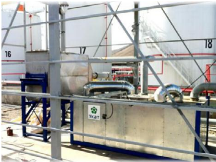
Общий вид термokatалитической установки очистки газовых выбросов
